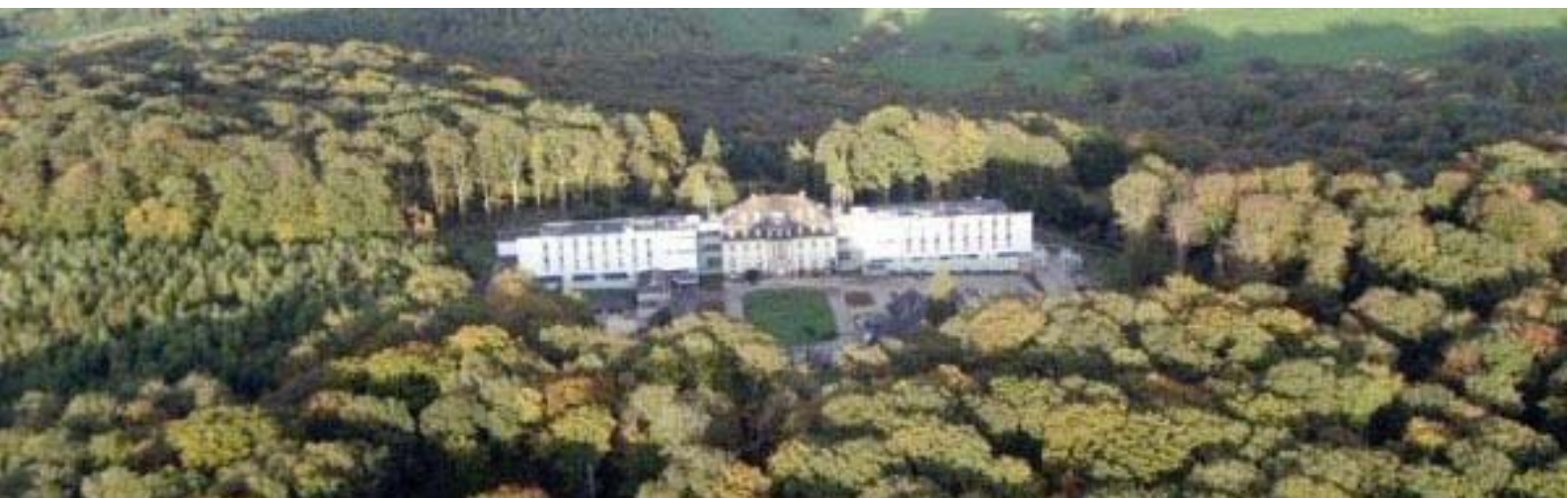
L'établissement après les travaux d'agrandissement
